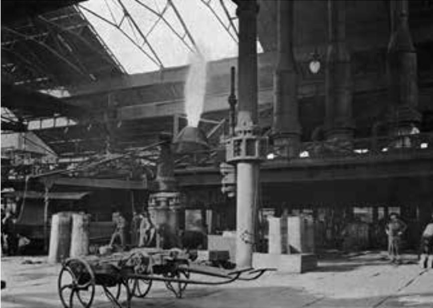
**Figura 17.** Plataforma y convertidores de acero Bessemer.
