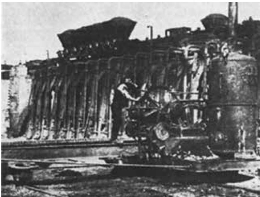
**Figura 10.** Batería de hornos de cok. 1882.
