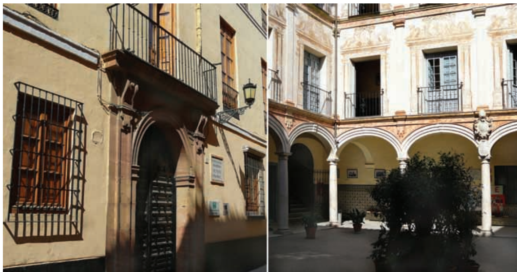
5.10. Sede de la primitiva Escuela Industrial, de Comercio y de Náutica de Málaga (1851-1857), en la calle Gaona. Hoy es el Instituto Vicente Espinel, vulgo Instituto Gaona. Está proyectada en él la instalación de la nueva Facultad de Bellas Artes. En dicho Instituto hizo el bachillerato Severo Ochoa (fot.: J.M.C.P.).
