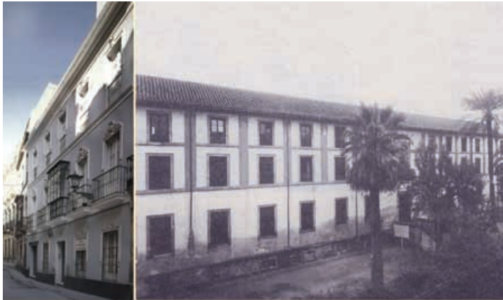
Fachada de la línea interior reformada
