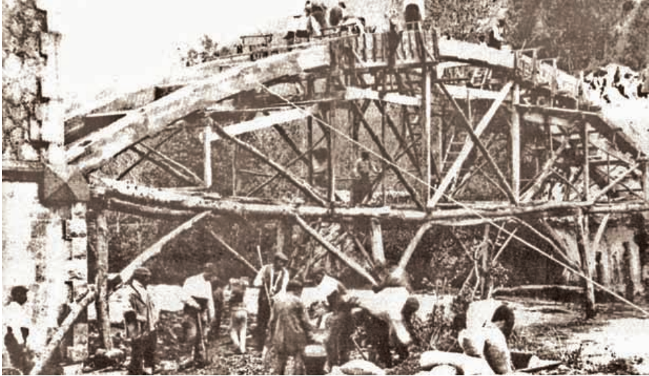
8.3. Construcción en hormigón armado: La construcción del puente de Golbaro, Santander, diseñado por J. Eugenio Ribera (1900).
